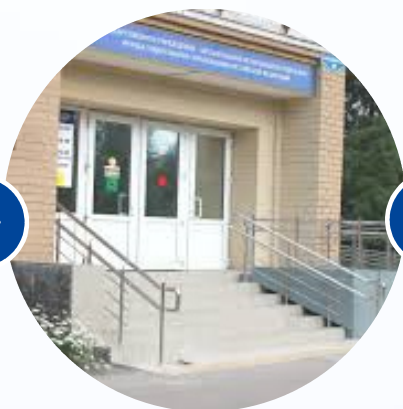
2. Вход (входы) в здание
