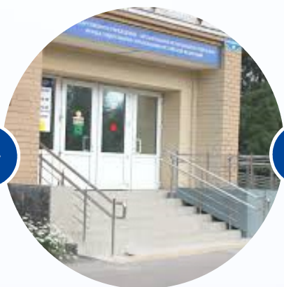
2. Вход (входы) в здание
